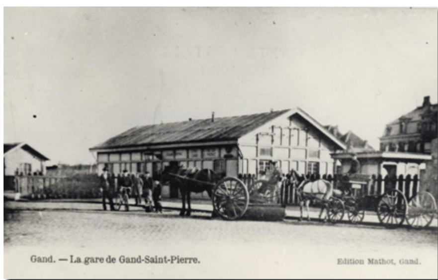
▲ Het eerste, nog houten, gebouw dat dienst deed als station Gent Sint-Pieters.
